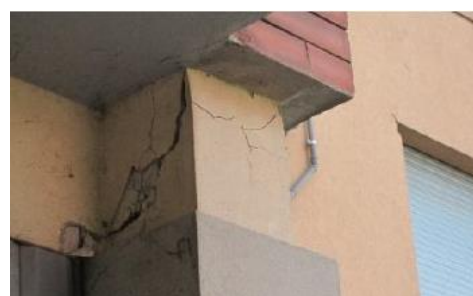
Fig. 3 Crisi di un nodo per taglio
